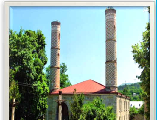
5. Ağdamın Gövher Ağa camisinin İranlı iş adamları tarafından restore edilerek fars abidesi gibi tanıtılması
